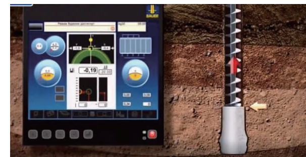
提升混凝土灌注及仪表显示情况
