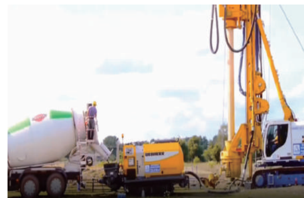
混凝土泵车泵送
