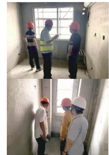
现场检查关键施工节点
