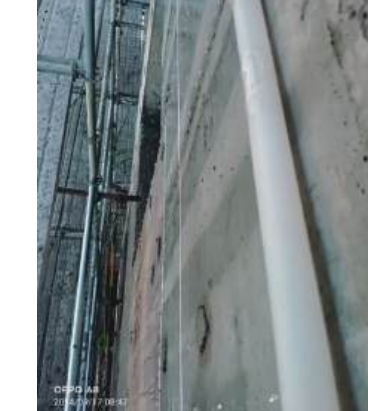
外墙穿墙螺杆封堵淋水试验
