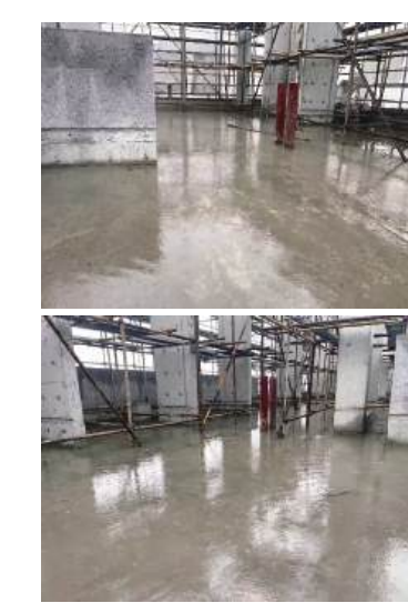
屋面结构蓄水试验
