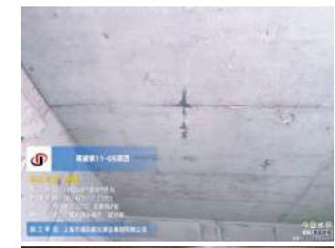
现场检查关键施工节点
