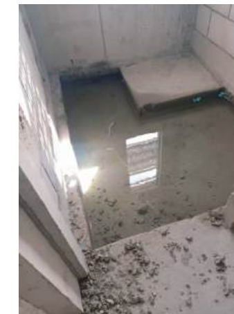
厨卫间二次吊洞蓄水试验
